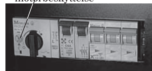
Justering af motorbeskyttelse
